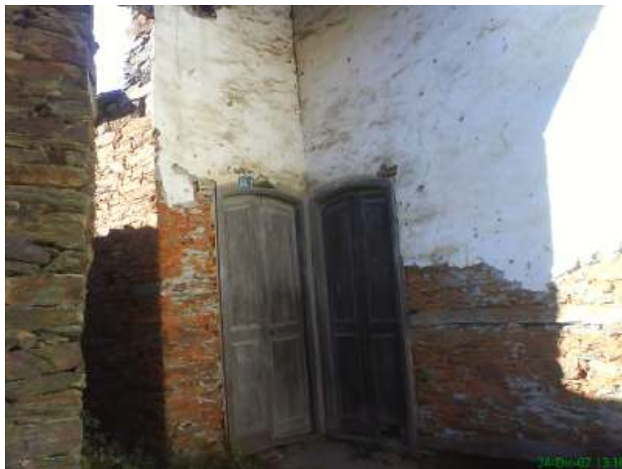
Estado Inicial. Zona Acceso
