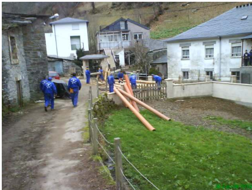
Zona de acondicionado da madeira para o armado da cuberta
