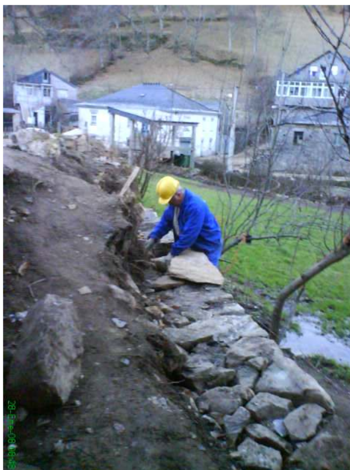
Reconstrucción do muro de contención de acceso planta baixa
