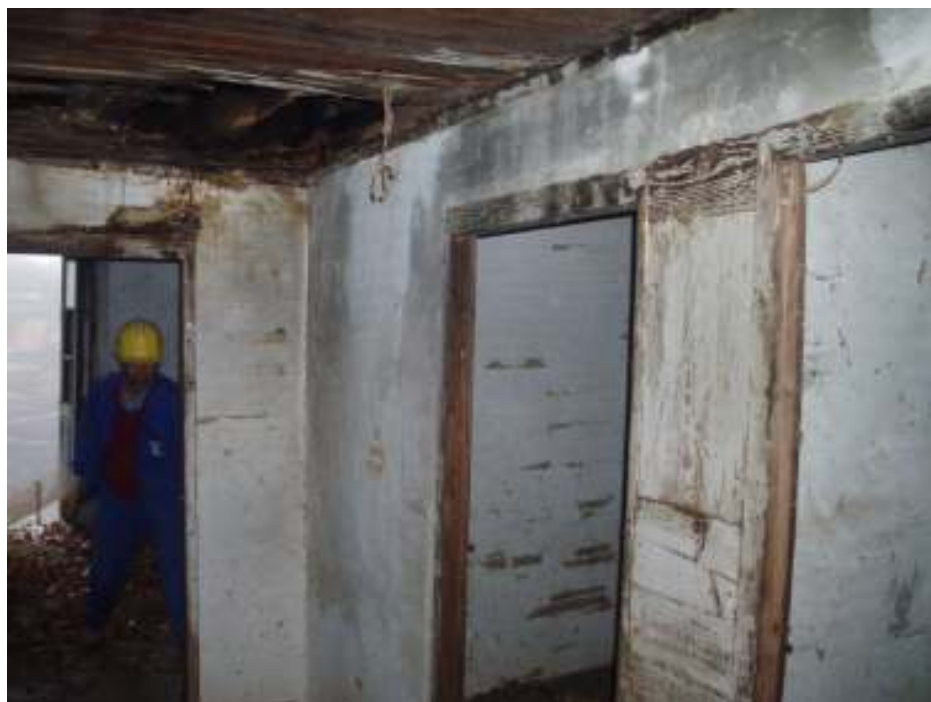
Estado inicial. Interior
