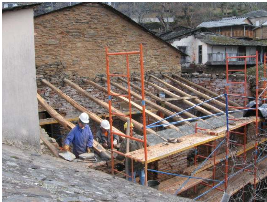
Reconstrucción armado, enlatado e lousado tradicional
