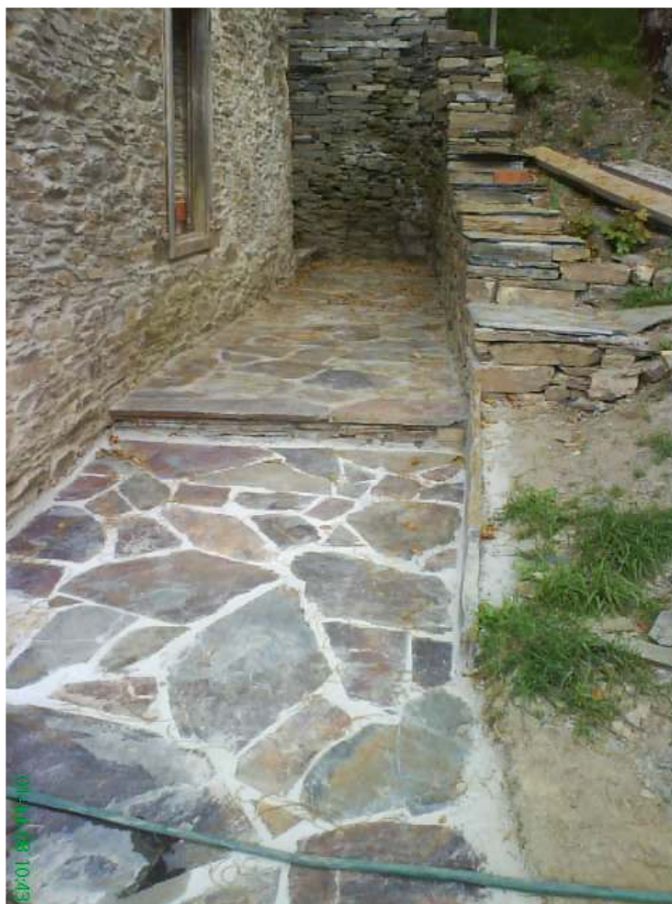
Accondicionado exterior. Muros de contención e solados
