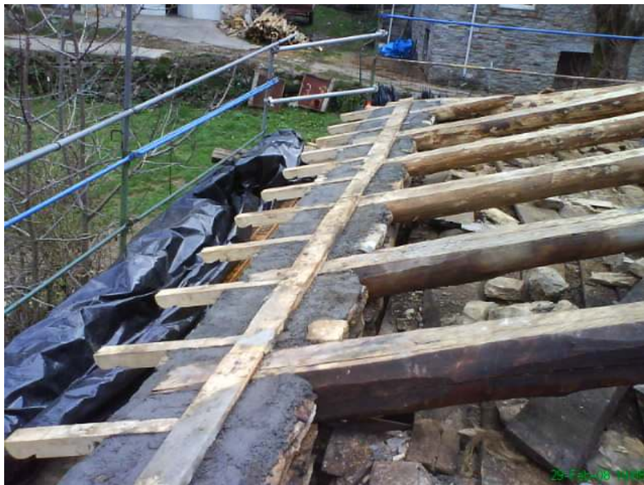
Armado da cuberta previa a colocación da lata e da lousa
