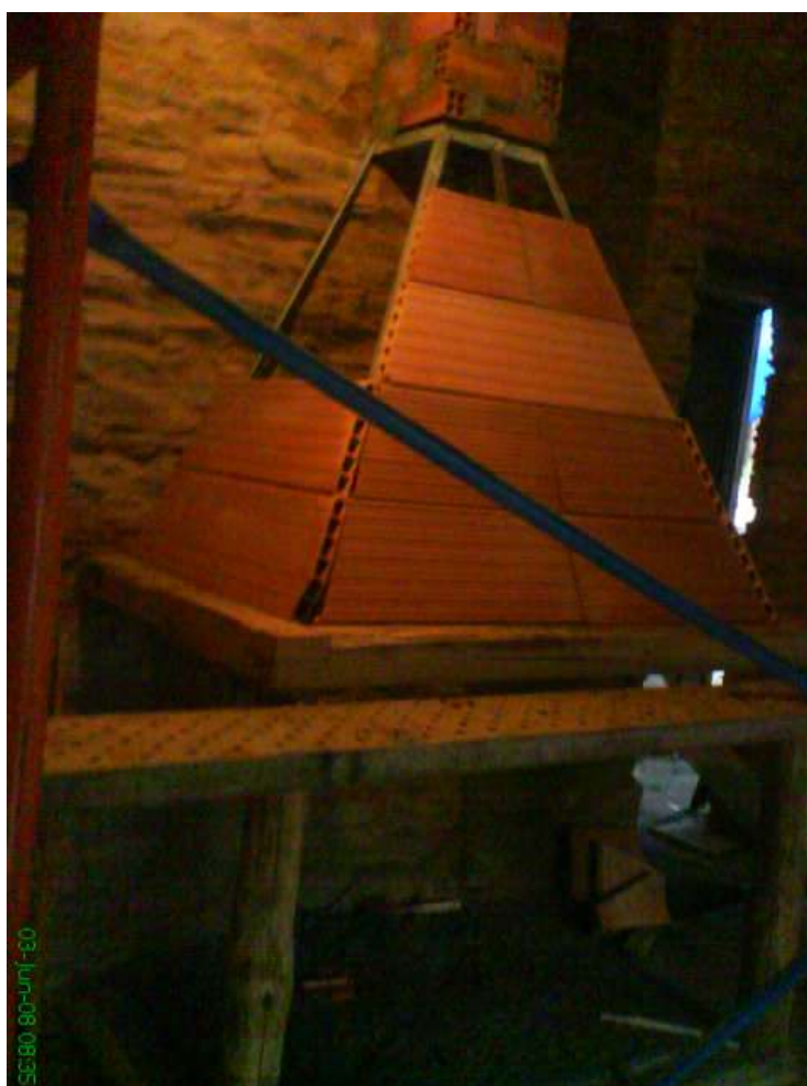
Construcción da cambota e cheminea
