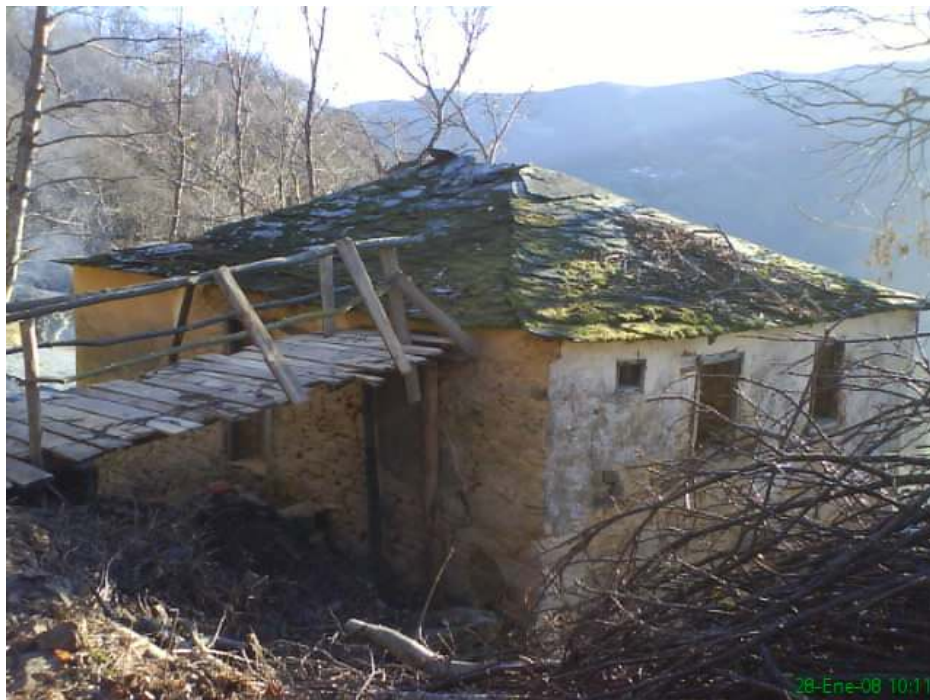
Estada para a demolición e reconstrucción do tellado
