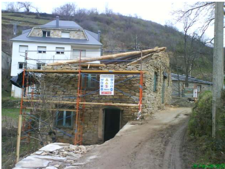
Andamiaje perimetral. Estado previo a reconstrucción do lousado
