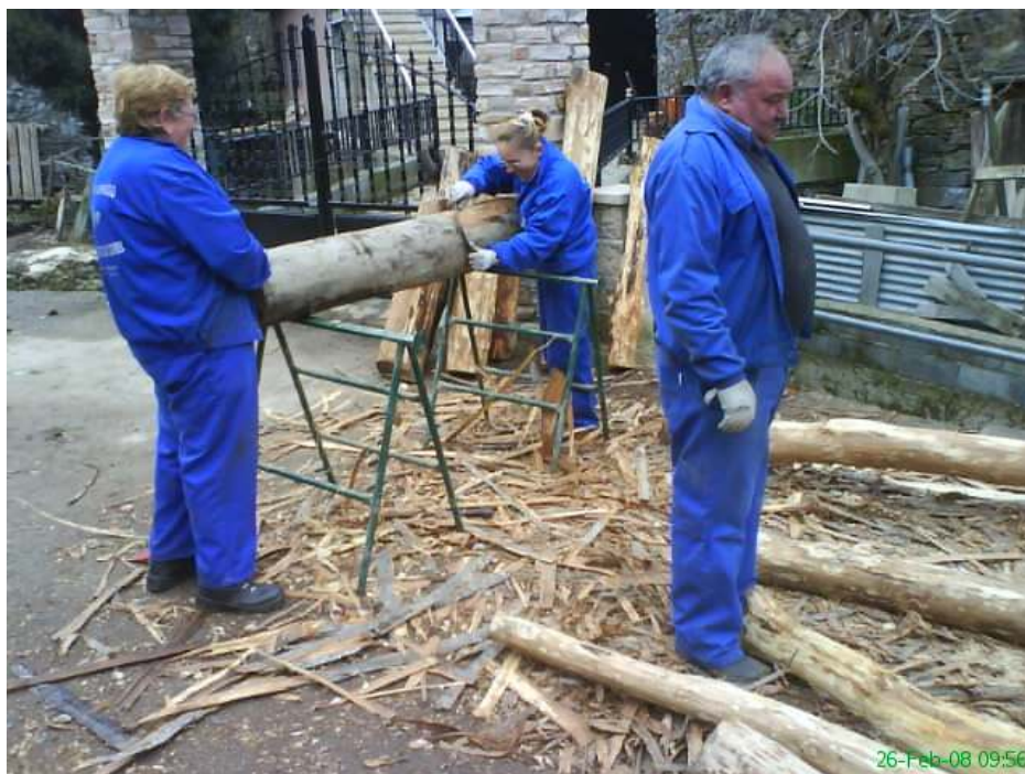
Preparación da madeira para o armado da cuberta
