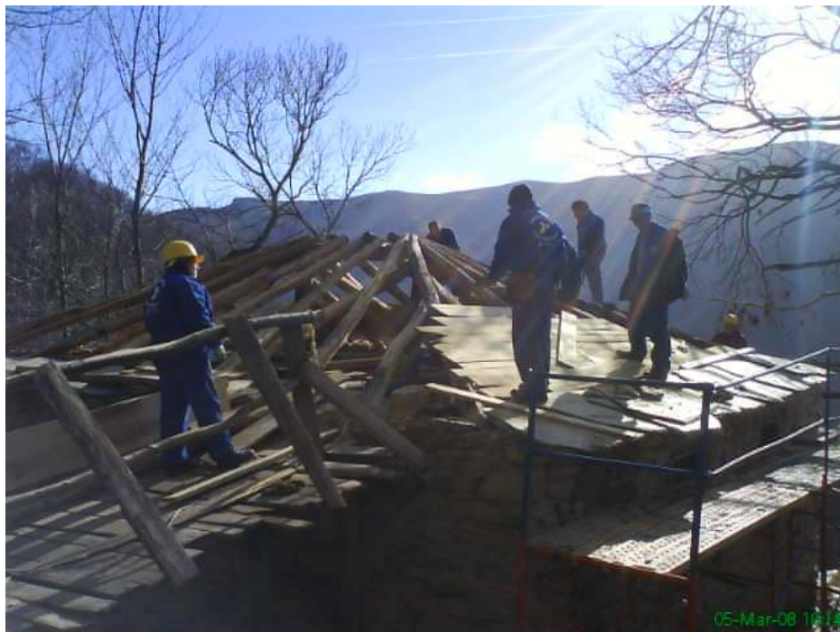
Reconstrucción do armazo e enladrado para o lousado
