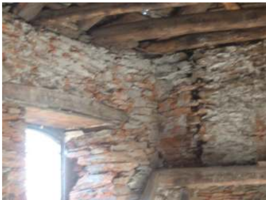
Estado inicial. Muro e zona demolida e reconstruída
