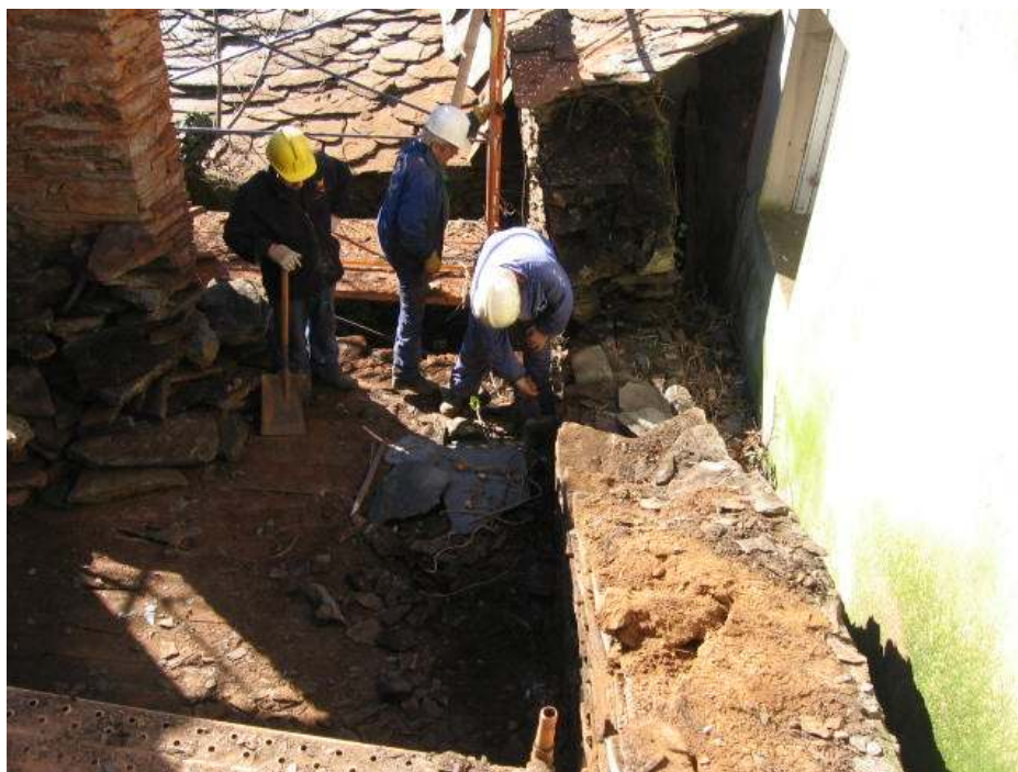
Demolición e reconstrución de muros en pedra tradicionais
