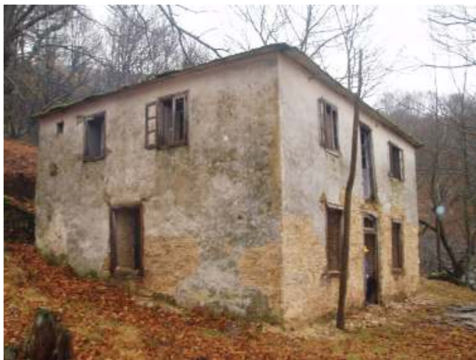
Estado inicial. Exterior
