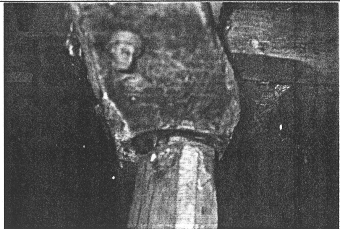
ENCAIXE MONTANTE - VIGA
